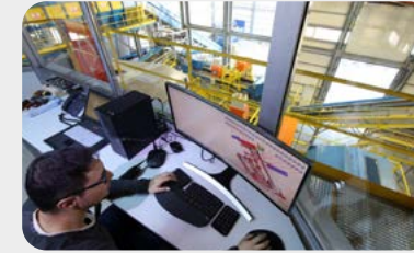
1 OTOMATİK KONTROL ODASI (SCADA)
